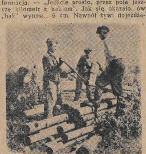
Pracę przy budowie szybu znaleźli również okoliczni mieszkańcy: z lewej do prawej ob. Jan Ślusarczyk, Marciniak ze wsi Piesiekierz Rudy, Jan Kopusta ze wsi Bronie
