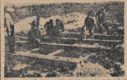
Już postawiony został fundament pod wieżę wiertniczą
