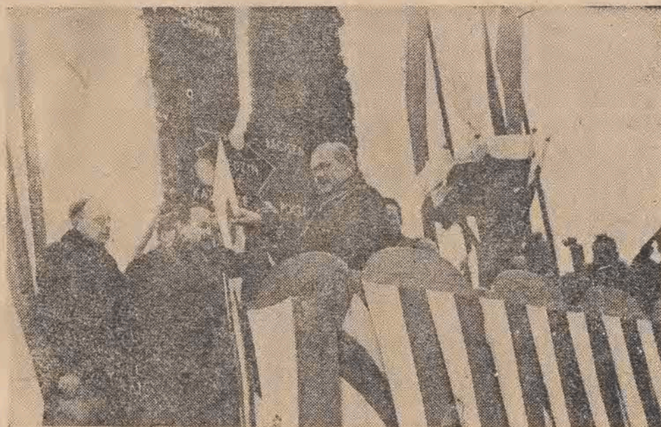
19 b. m. odbyło się pod Łodzią uroczyste otwarcie linii wysokiego napięcia łączącej dwa największe ośrodki przemysłu Polski: Łódź i Górny Śląsk. Linia została wybudowana w rekordowym tempie i wyłącznie przy użyciu materiałów krajowych. (Na zdjęciu — Min. H. Mine, który po dokonaniu symbolicznego uruc homienia linii, dekorował pracowników zasłużonych przy jej budowie).
