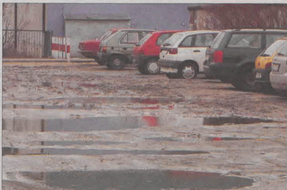
Zamiast błota betonowa kostka. Mieszkańcy bloków nr 8 i 9 na osiedlu Starzyńskiego po kilku latach próśb, będą mieli w końcu parking z prawdziwego zdarzenia.
