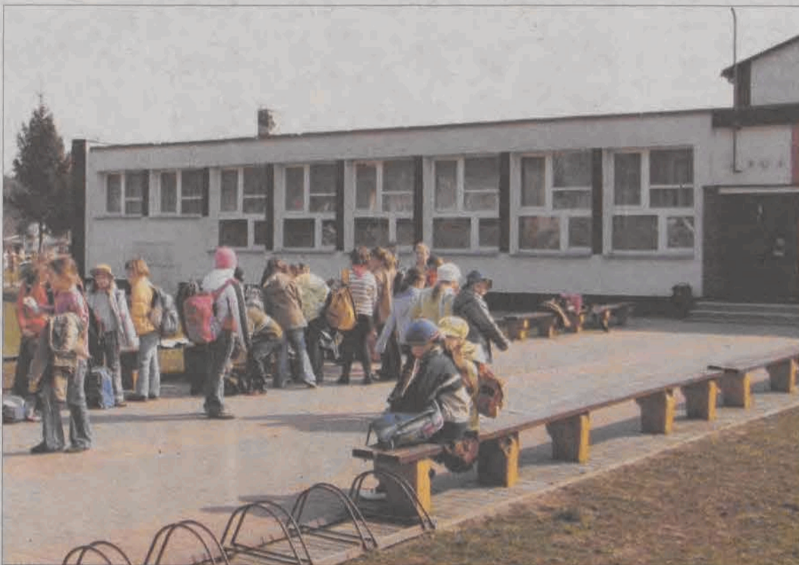
Nadbudówka powstanie nad widoczną częścią budynku szkoły podstawowej. Kształt dachu podobny będzie do już istniejącego na stojącym z tyłu budynku gimnazjum.
