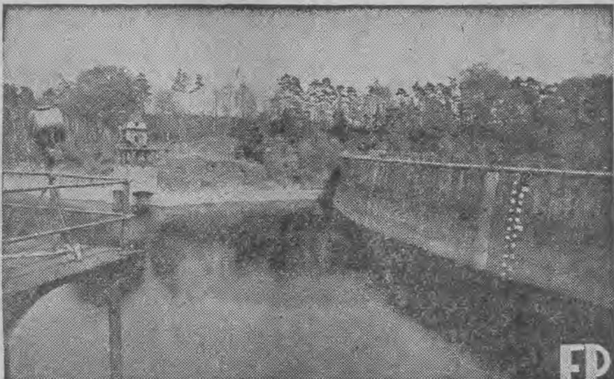
Na jeziorach w powiecie lubańskim olbrzymia tama spętrza wodę na wysokość 35 metrów. Elektrownia znajdująca się poniżej, zasilana wodą posiada siłę 3.000 KW. Klucz elektrowni w Leśnej zasila w prąd cały okręg wrocławski. (Na zdjęciu zaporę wodną i elektrownię w Leśnej k. Lubania na D. Śląsku).
