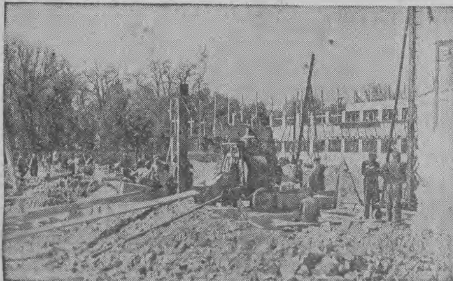
Wrocław z każdym dniem staje się ładniejszy. Nie dziwne: przygotowuje się jak może najstaranniej i „zapina na ostatni guzik” przed mającym niebawem nastąpić otwarciem Wystawy Ziemi Oczyszczonej. Na zdjęciu — prace przy budowie Wystawy — fragment wznoszenia pawilonów wystawowych.
