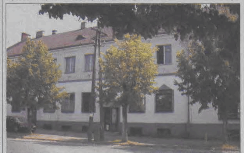
Być może już niedługo zmieni się wygląd tego budynku
