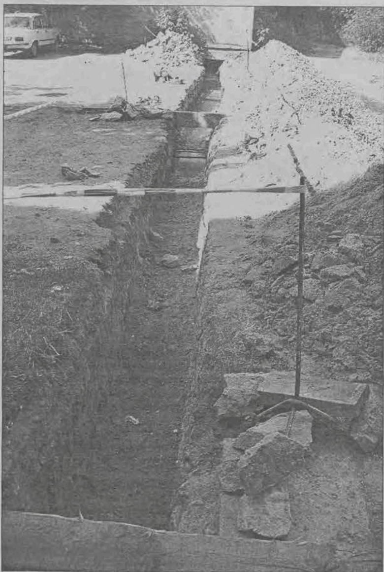
Trzy bloki na osiedlu Kopernika zostaną podłączone do „spółdzielczej” kotłowni.
