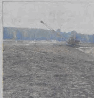
Obecnie trwają prace przy obwałowywaniu zbiornika.
