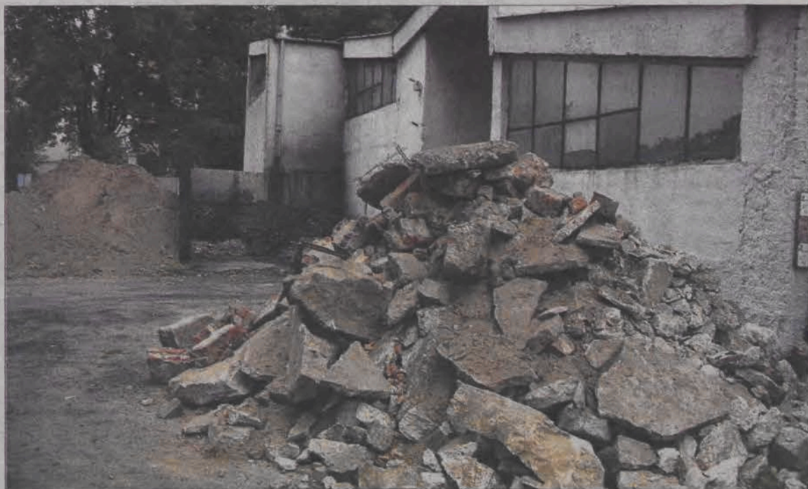
Prace przy modernizacji miejskiej sieci ciepłowniczej - jednej z efektów utworzenia spółki ZEC.
