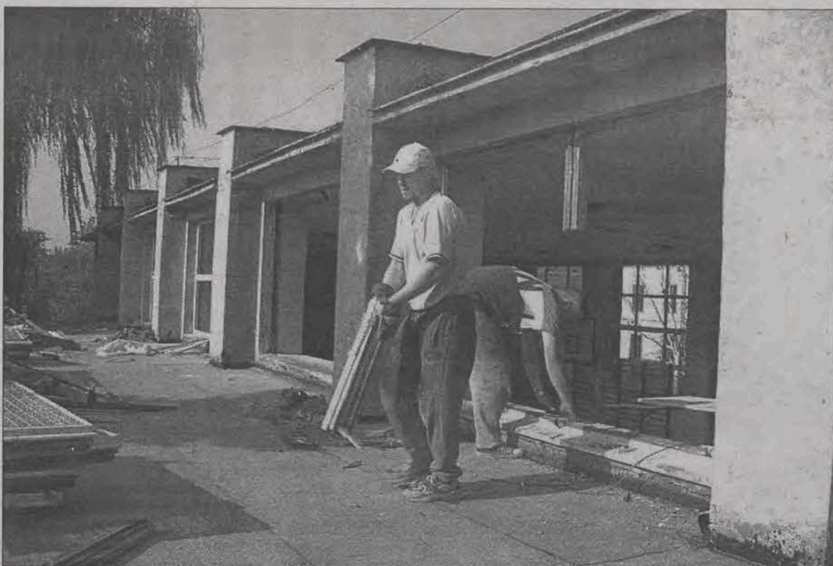
Trwa wymiana okien w budynku Liceum Ogólnokształcącego im. J. Chelmońskiego w Łowiczu. Wymieniane są okna w sali gimnastycznej, w pomieszczeniach gospodarczych i na korytarzach. Prace wykonuje P.P.H.U. „Rapid” z Łowicza. Ich koszt wyniesie ponad 117 tys. zł, z czego 82 tys. zł to pożyczka, jaką powiat otrzymał z WFOŚ, 20 tys. zł to środki Rady Rodziców, a pozostała część to pieniądze z budżetu powiatu. Zakończenie prac planowane jest jeszcze w październiku. Zdjęcie zrobiono podczas prac w górnej części sali gimnastycznej. (mwk)
