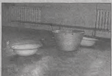
Balie, miski i wiadra ratują sytuację w zalanej sali do ćwiczeń rehabilitacyjnych.
