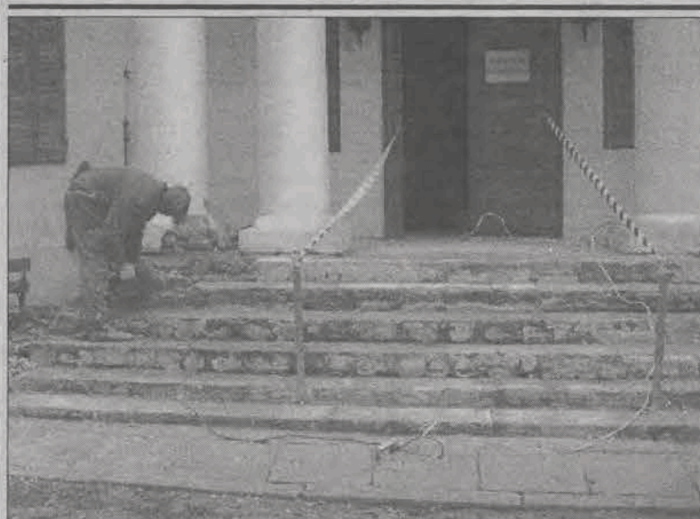
Schody w dworku doczekały się remontu. Na kilkanaście dni przed wyborami powyszczerbiane schody wejściowe w dworku przy ul. Dworskiej 4 doczekały się remontu. Prowadzi go głowieńska firma RESTOL-BUD. Prace polegać będą nie tylko na wymianie nawierzchni schodów, ale również na zmianie ich profilu oraz dostosowaniu do potrzeb osób niepełnosprawnych. Łączny koszt remontu to ok. 8 tys. zł.
