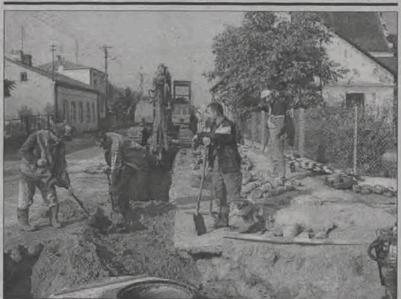
Rozpoczęły się prace na ulicy Skierniewickiej w Bolimowie związane z budową kanalizacji. To ostatni etap budowy. Jeżeli zima nie przyjdzie zbyt wcześnie, kanalizacja zostanie oddana jeszcze w tym roku. (mko)
