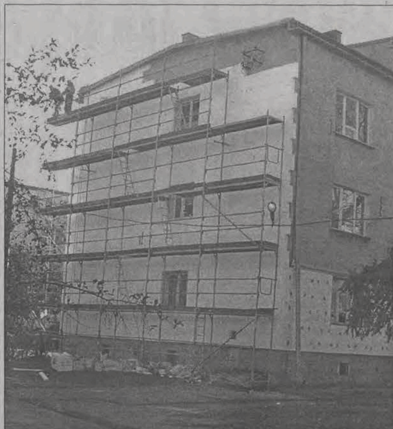
WIKAM rozpoczął docieplanie od szczytów budynków
