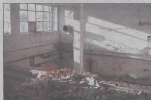
Modernizacja starych hal oznacza niekiedy budowanie ich niemal od nowa.
