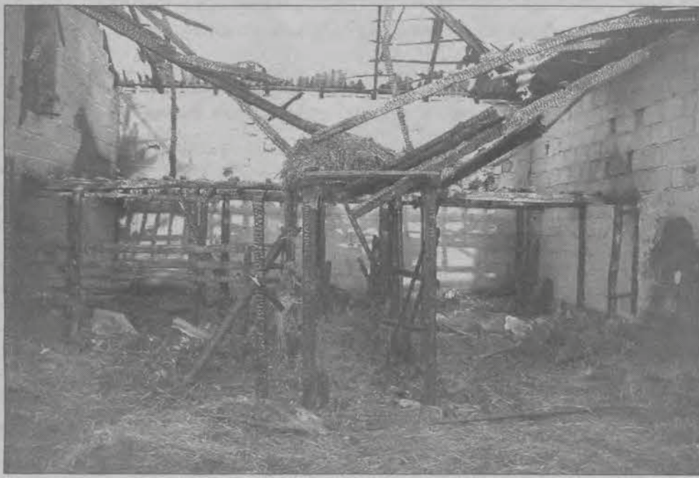
W tej części budynku stały krowy. Siedem z nich udało się uratować, siedem niestety spłonęło
