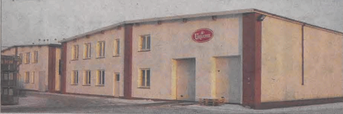
Zabudowania produkcyjne na Katarzynowie. Na pierwszym planie jeden z magazynów wyrobów gotowych.
