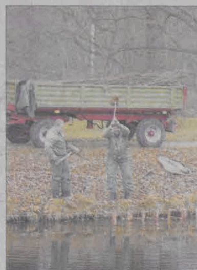
Trwają prace przy umacnianiu brzegów kanału łączącego parkowe stawy.
