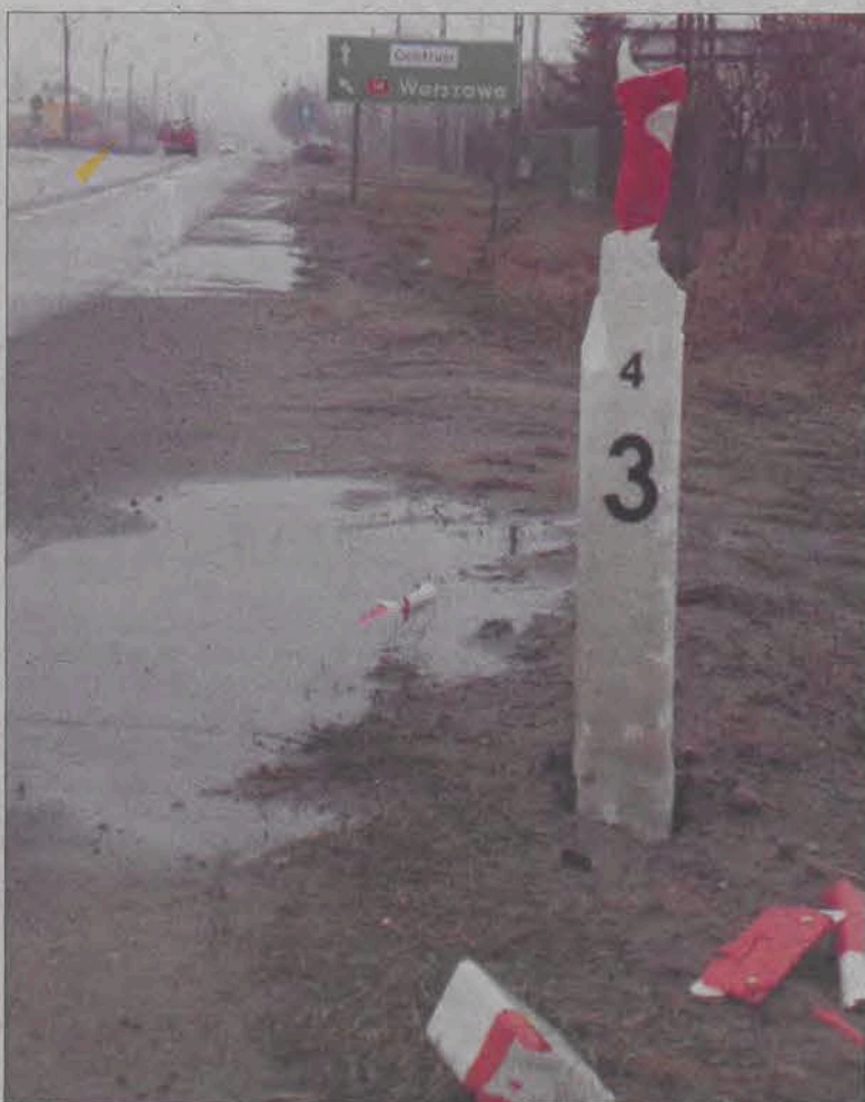
Zniszczonych pacholtek na odcinku drogi krajowej nr 14 pomiędzy Łowiczem a Krępą jest ponad 100. Fot. Zarząd Dróg Krajowych.
