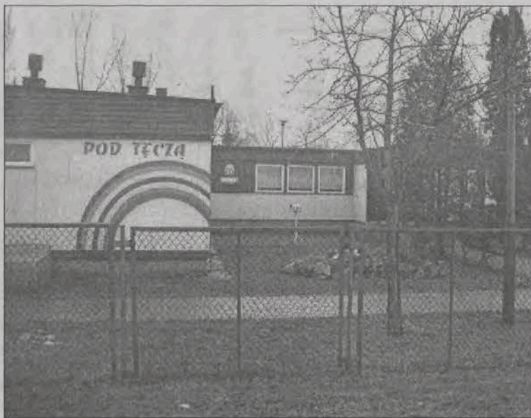
Budynek przedszkola, wokół którego ostatnio narosło wiele niejasności i kontrowersji.
