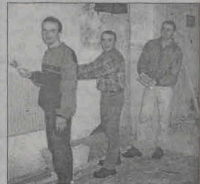
Uczniowie klasy V technikum z zapalem pracują przy remoncie siłowni szkolnej.
