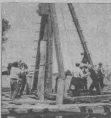
Regulacja Słudwi - wbijanie drewnianych pali mostowych - 1930 r.
