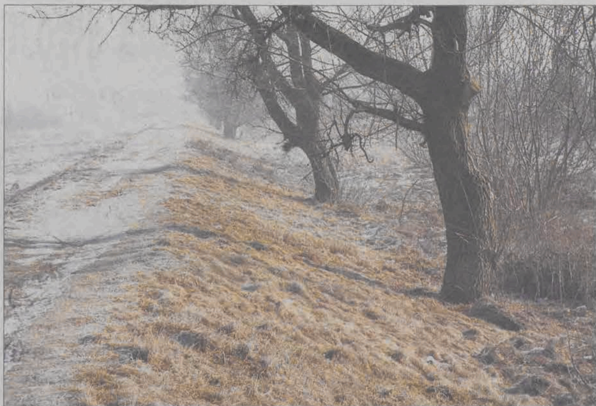
Te drzewa korzeniami uszkodzają podstawę wału, w przyszłości może to mieć katastrofalne konsekwencje.
