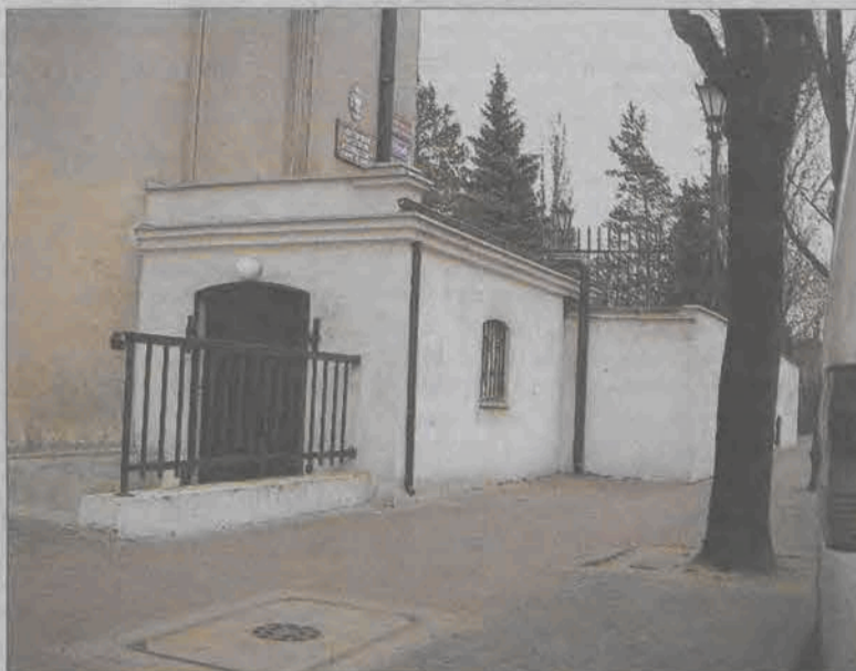
Wejście do piwnic, w których będzie restauracja zbudowano od strony ulicy 3 Maja.
