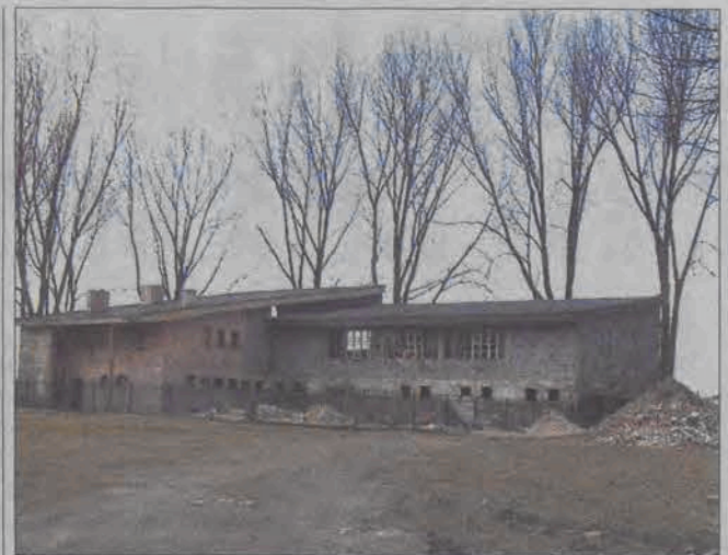
Prace przy przebudowie „Szkielki” szybkim krokiem idą do przodu. Część barowa ma być już otwarta w czerwcu.
