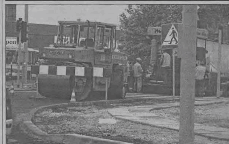
Od poniedziałku na modernizowanym odcinku trasy nr 14 w pobliżu stacji paliw i supermarketu PLUS, pracował sprzęt ciężki, przy użyciu którego nakładano asfaltowy dywanik.
