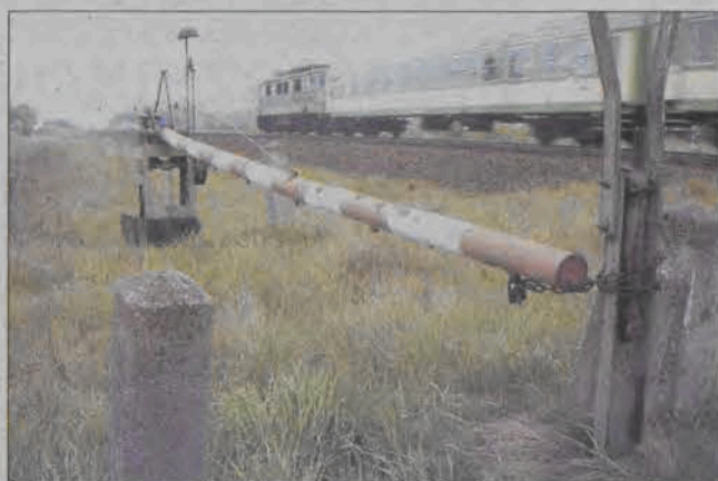
Przejazd kolejowy jest od lat nieużywany, a droga dojazdowa do niego zarosnięta jest wysoką trawą.
