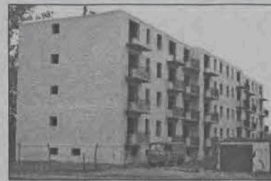
Na początku czerwca w bloku zamontowane mają być okna
