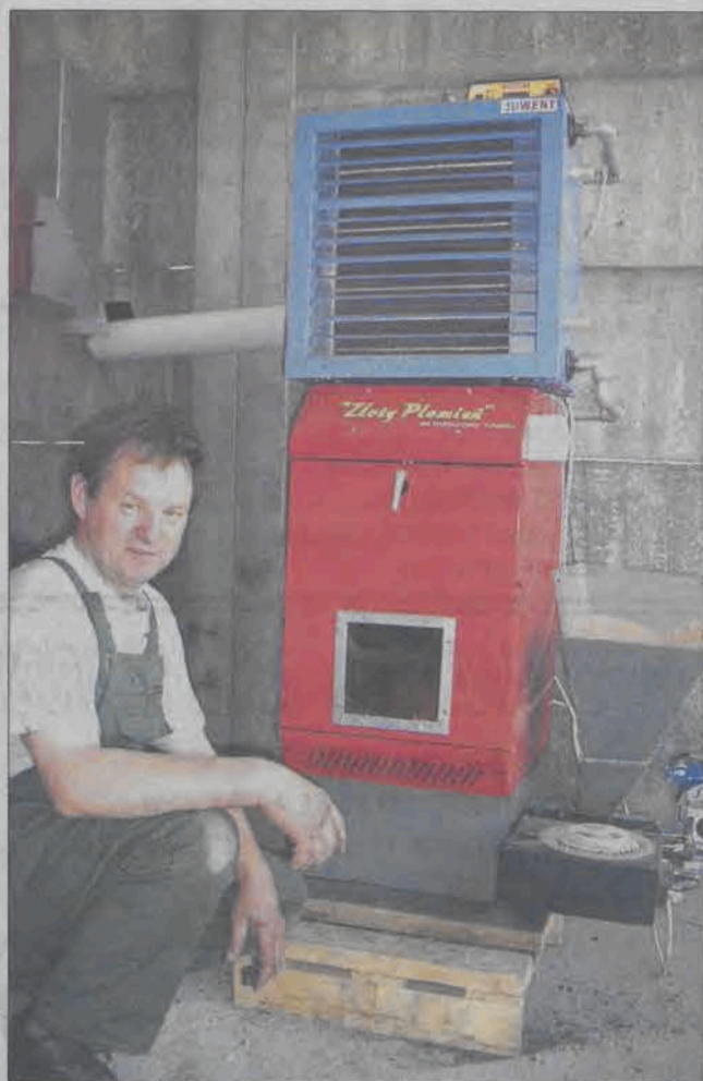
Przy piecu, na terenie Gumitexu, jeden z tych, którzy własnymi rękoma tworzyli urządzenie - Ryszard Tomasiwicz.
