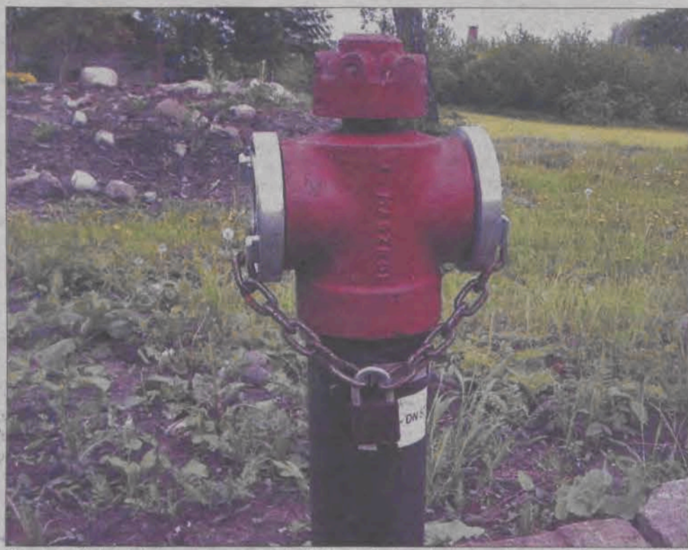
By utrudnić kradzieże wody, w gminie Bielawy dostęp do hydrantów zamknięto na kłódki.
