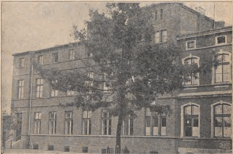
Außenansicht des neuen Greisenheims der St. Trinitatis-Gemeinde zu Łódź, dessen Einweihung am 15. Juni 1933 stattfand.
