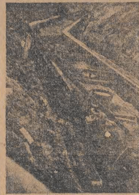
Nowe koryto Łódki w budowie
