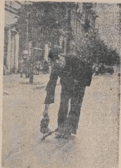
Nie, to nie malkontentni; ob. Wróbel jest najpracowitszym konserwatorem ulicznych asfaltów. „Zatyka” dziennie do 500 szczelin w jezdni.
