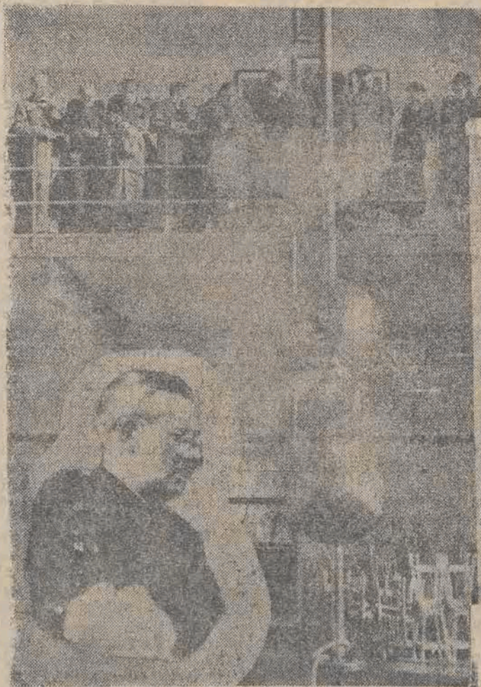
W Warszawskim Instytucie Elektrotechnicznym została wybudowana specjalna hala t. zw. „najwyższych napięć”. (Na zdjęciu fragment hali oraz monier odbudowy naszego przemysłu, min. Hilary Minc, którego przemówienia z okazji otwarcia hali wysłuchano z zainteresowaniem).
