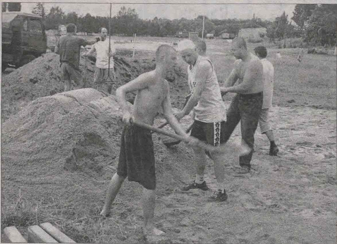
Nowe boisko w sąsiedztwie kąpieliska. Trwają prace przy budowie boiska dla minikosza na terenie byłego MOSiR w sąsiedztwie kąpieliska nad „Mroźczką”. Już kilka lat temu, przy udziale młodzieży, w miejscu, na którym powstaje utwardzone boisko, ustawiony został kosz do gry w minikoszykówkę. Inicjatorem tego przedsięwzięcia był prezes TKKF „Expandor” Eligiusz Zieliński. Dziś ten ostatni jest koordynatorem prac przy budowie boiska. Boisko powstaje przy zaangażowaniu młodzieży z osiedla Swoboda. Koszka brukowa, jaką zostanie ono wyłożone pochodzić będzie z MZK i została przekazana nieodpłatnie. Prace ziemne przy użyciu „Ostrówka” wykonywane są dzięki uprzejmości MZWiK. (rpm)
