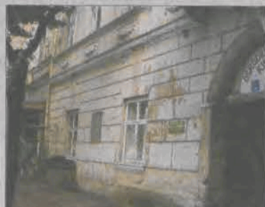
Remont elewacji i wymiana okien na pewno się przyda budynek nie wygląda bowiem od frontu zbyt okazale.
