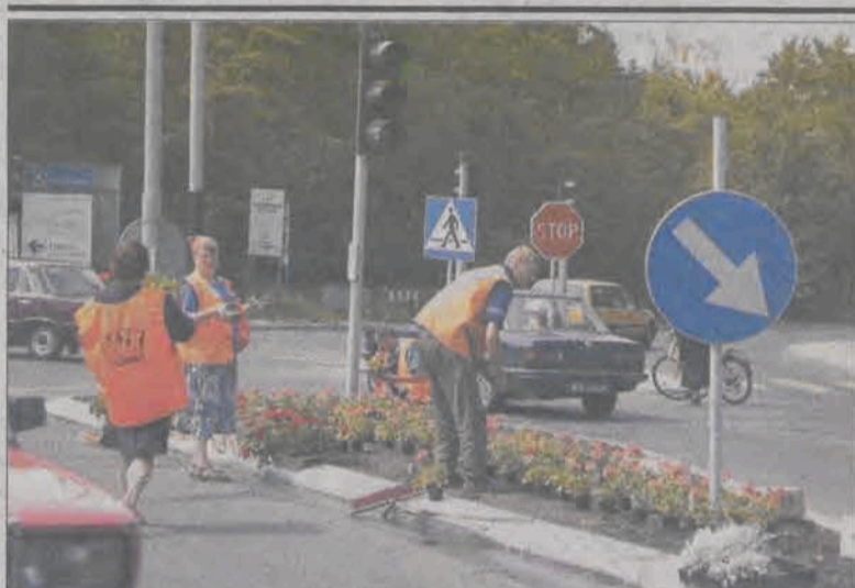
We wtorek 1 lipca na klombach przy remontowanej trasie nr 14 „zakwitły” pelargonie.
