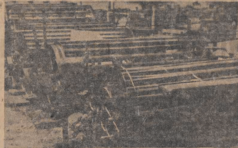
Maszyny rdzewieją pod deszczem...
