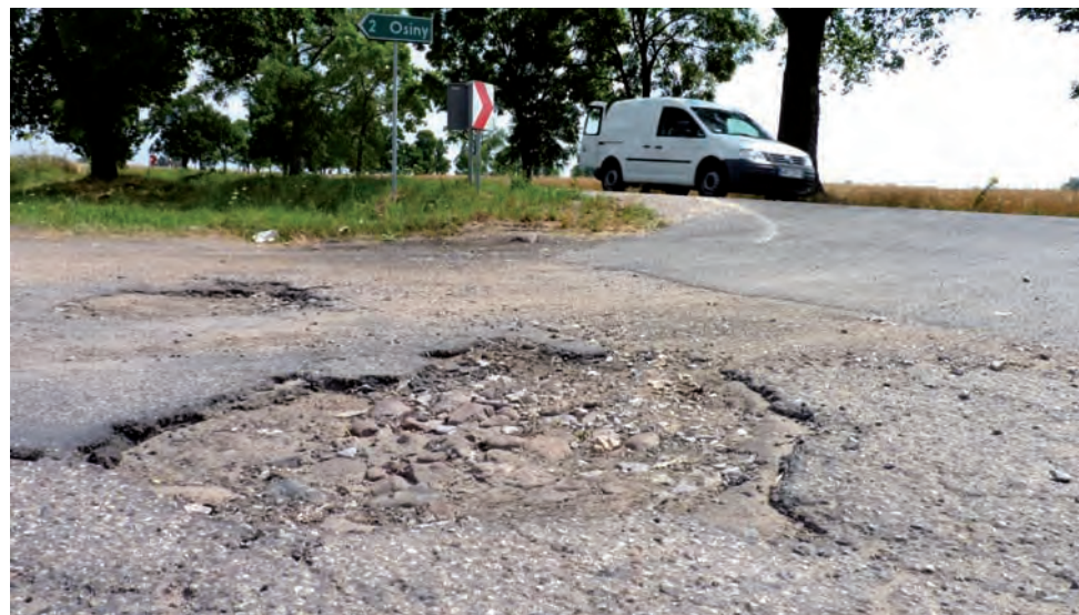
Zjazd na Osiny. Dwie dziury na głębokości kilku centymetrów stwarzają poważne zagrożenie dla bezpieczeństwa kierowców.
