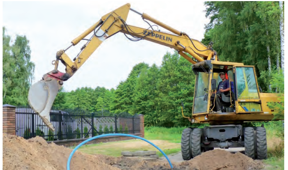
Budowa kanalizacji na ul. Akacyjowej w Domaniewicach. Podwykonawcą inwestycji jest firma Melkan, której koparka 20 lipca pracowała przy ostatniej już posesji na tej ulicy.
