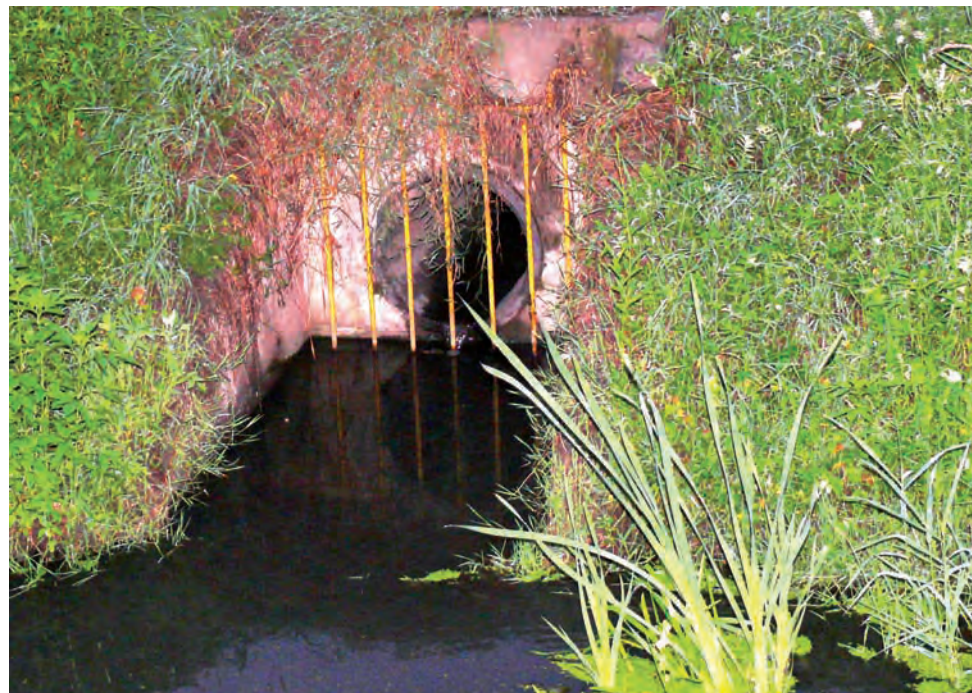
Jedno z sześciu ujść kanalizacji deszczowej do kanału Malinówka, są one w części odpowiedzialne za napełnianie go wodą.
