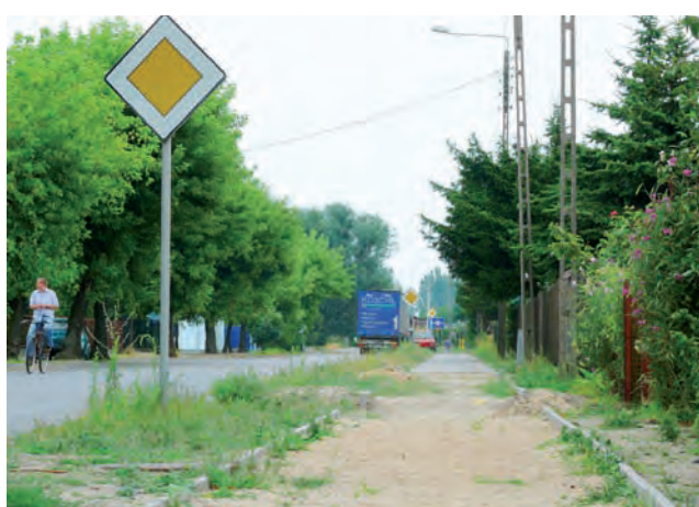
Chodnik na ulicy Radzieckiej czeka na dokończenie , będzie to możliwe dopiero po zdemontowaniu kolejnej partii kostki przy 3 Maja.
