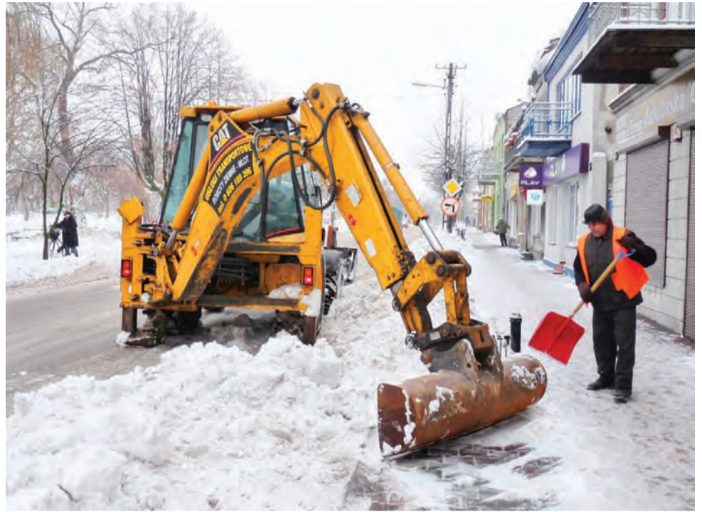
Środa, 13 stycznia - usuwanie przyzmy śniegu usypanego wzdłuż ulicy Łowickiej.
