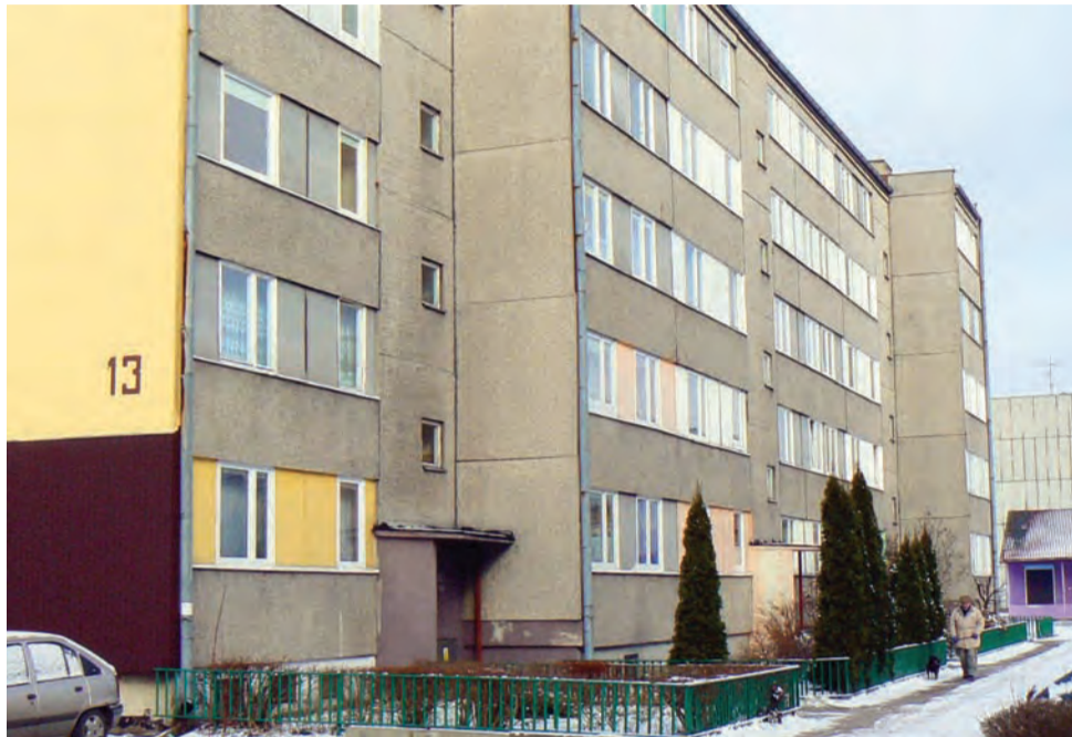
W tym roku docieplona zostanie elewacja tego bloku na os. Kopernika.
