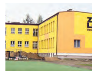
Większość prac dociepleniowych już została wykonana.
