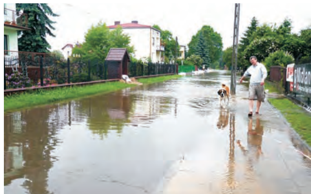
Ulica Łąkowa, ok. godz. 18.00. Pod wodą znalazła się droga i chodnik, a także ogrody i piwnice w budynkach.
