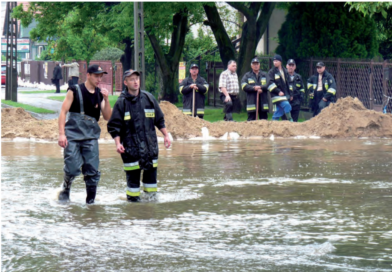
Poranek 31 maja, ulica Kilińskiego, Mroga wystąpiła z koryta. Poziom wody szybko się podwyższał. Strażacy robili zapórę z worków z piaskiem, na podbudowie których usypywano ziemny wał.
