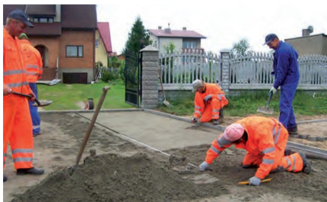
Budowa podjazdów na ul. Cmentarnej.
