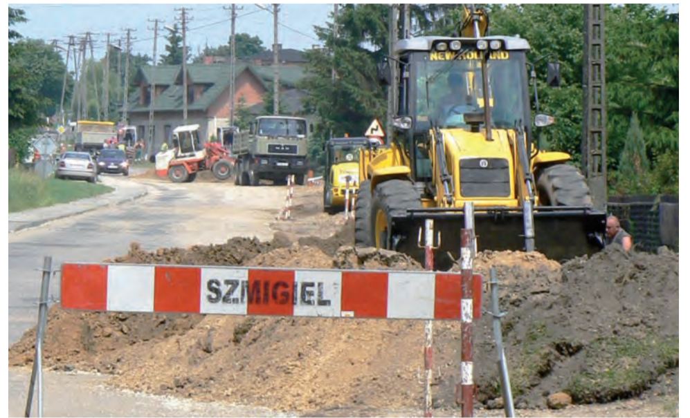
Budowa kanalizacji w Dmosinie. Maszyny i wykopy utrudniają ruch. Trzeba zwolnić.
