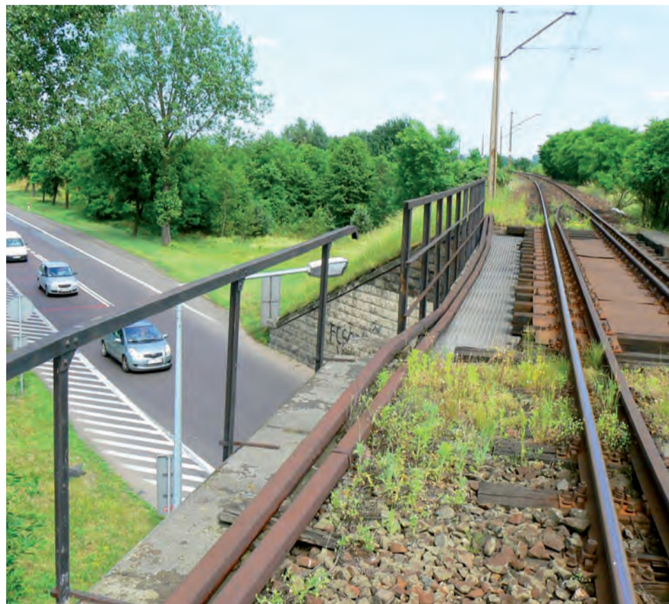
Wiadukt kolejowy nad szosą nr 14 w Krępie. Czy uda się go przebudować równocześnie z modernizacją torowiska?
