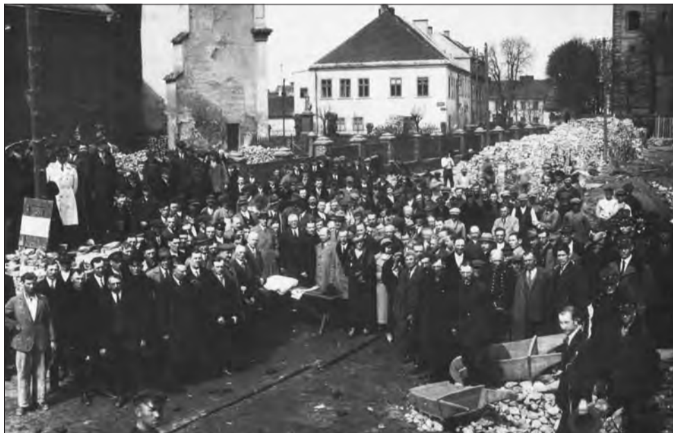
Uroczystość położenia kamienia węgielnego pod budowę Domu Ludowego w Łowiczu - 28 marca 1934r., fot. ze zbiorów Archiwum Państwowego w Łowiczu
