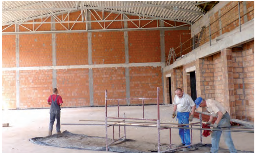
Budowa sali dla ZSP nr 3. Mury i dach są już gotowe. W tym tygodniu rozpocznie się montaż okien.
