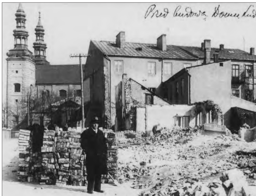
Starosta Zdzisław Maćkowski na placu budowy Domu Ludowego, fot. ze zbiorów rodzinnych K. Stępień z Wrocławia
