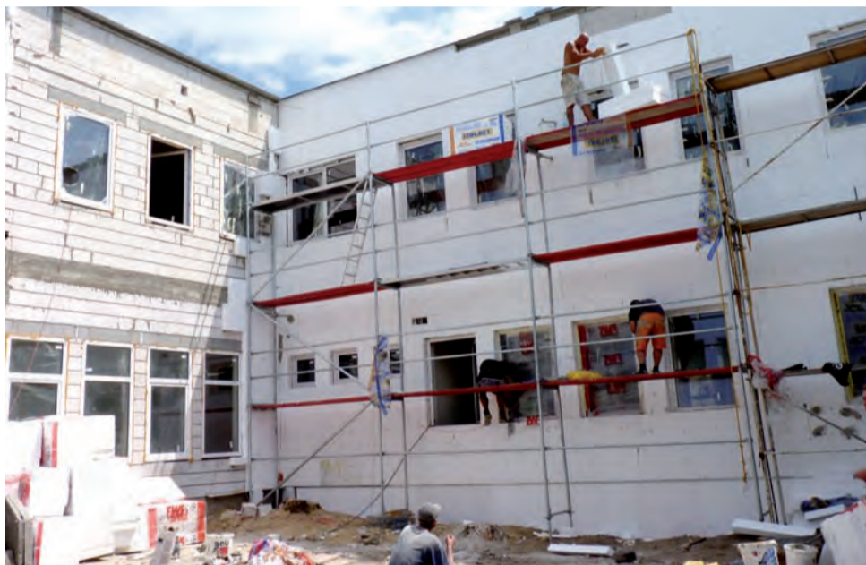
Budynek SOS-W. Trwają prace na elewacji od strony wewnętrznego atrium.
