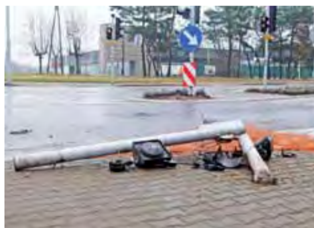
Skrzyżowanie Sikorskiego z krajową 14-stką. Na pierwszym planie sygnalizator uszkodzony 1 stycznia przez Hyundaią.
