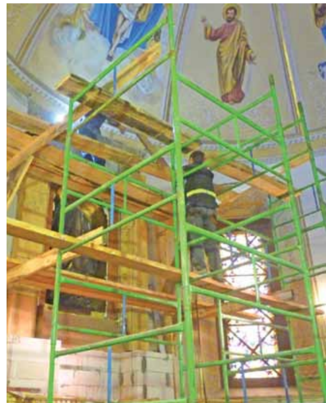
Prace remontowe przy ołtarzu w kościele św. Jakuba Apostoła.
