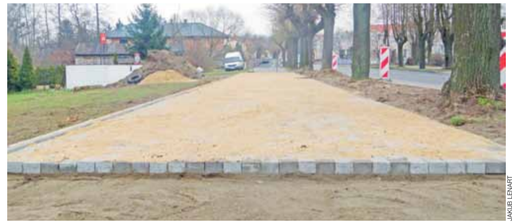
Chodnik przy ul. Swoboda już nabiera nowego kształtu.
