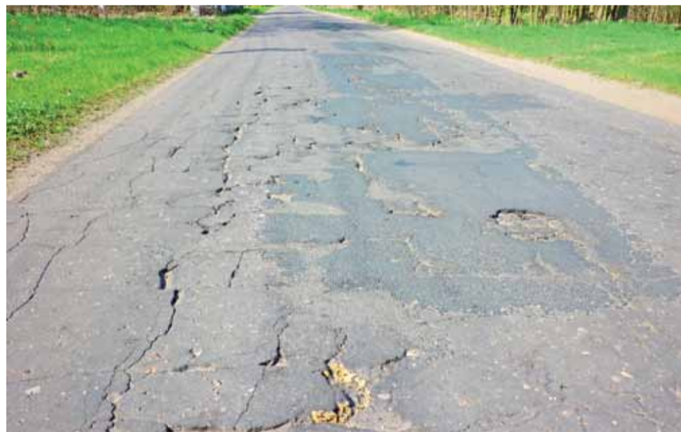
Droga gminna w Woli Zbrożkowej. O jej kompleksowy remont zabiegają mieszkańcy wsi.
