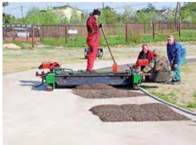
Pracownicy firmy Gretasport kładą nawierzchnię boiska.
