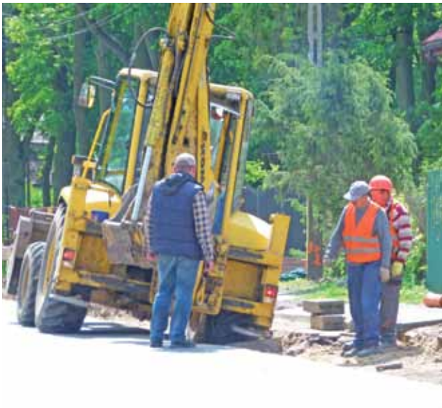
Realizacja inwestycji wymaga zrywania asfaltu, który po budowie kanalizacji ma zostać odtworzony.
