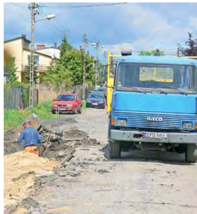
Prace na Złotej prowadzi firma Markbud.
