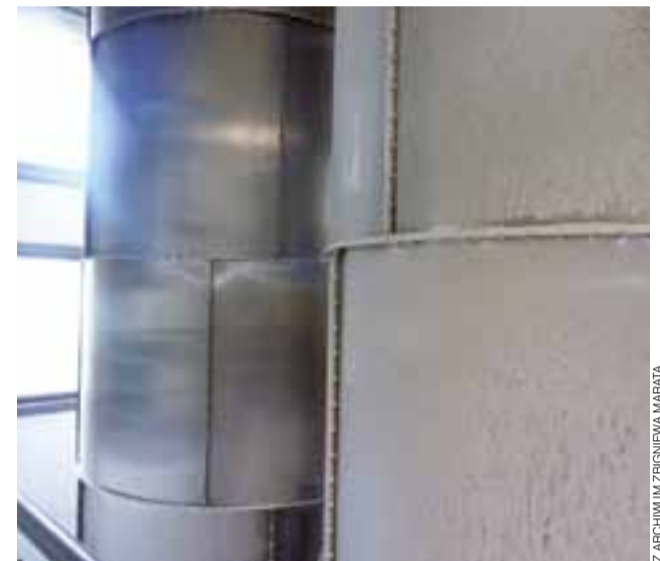
Od lewej: silos szczelny, obok silos nieszczelny. Widać, że obudowa nieszczelnego silosa pokryta jest pokładami mąki (jest to jedna z wad konstrukcyjnych zbiorników).
