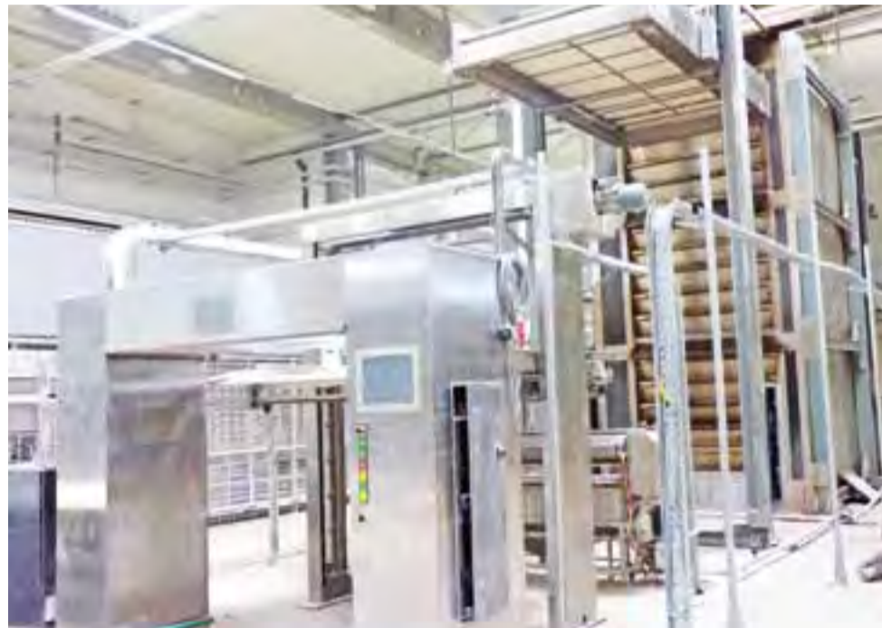
Jeden z nowoczesnych, 15-poziomowych pieców wyprodukowanych w Czechach. Teraz nie działa.
