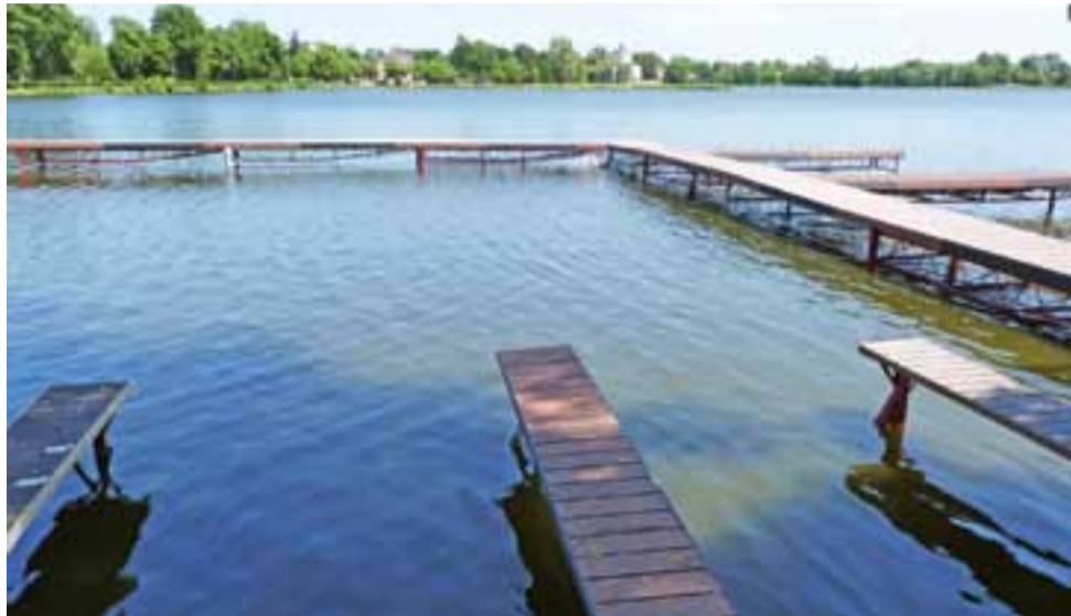
Pomost po remoncie został skrócony.
