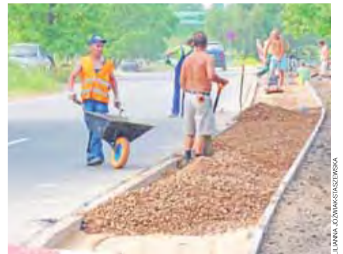
Budowa chodnika przy ul. Wczasowej. Zlecenie to realizuje firma Erbedim.
