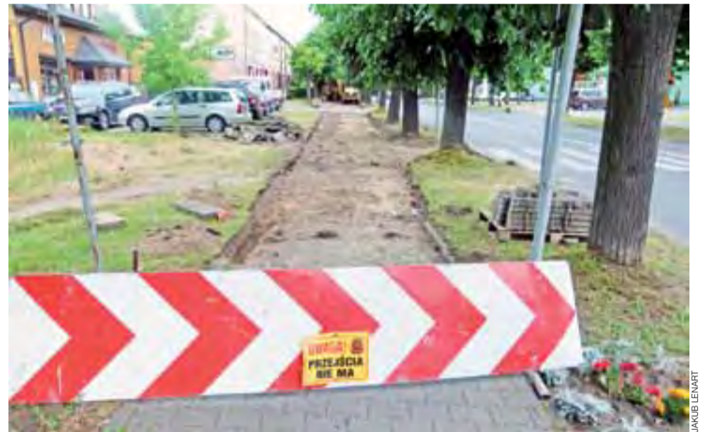
Stary chodnik już został rozebrany.
