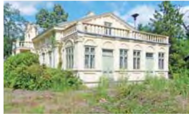
Otoczenie budynku jest zarosnięte krzewami i trawą.
