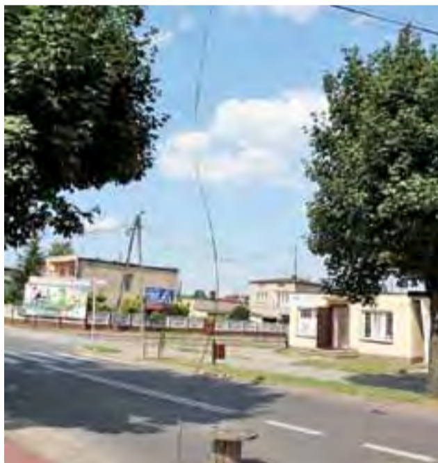
Zerwania linii energetycznej na Sikorskiego.
