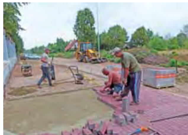
Najwięcej robotników i maszyn zaangażowanych w budowę „schetynówek” napotka się obecnie w Lipce.
