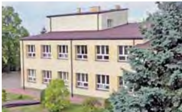
Gimnazjum w Bielawach z nowym dachem, stan na 24 sierpnia.
