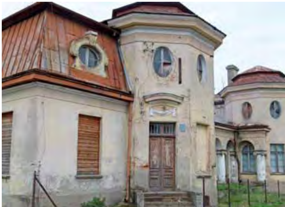
Pałac Rzewuskich widziany od strony bloków w Bratoszewicach.
