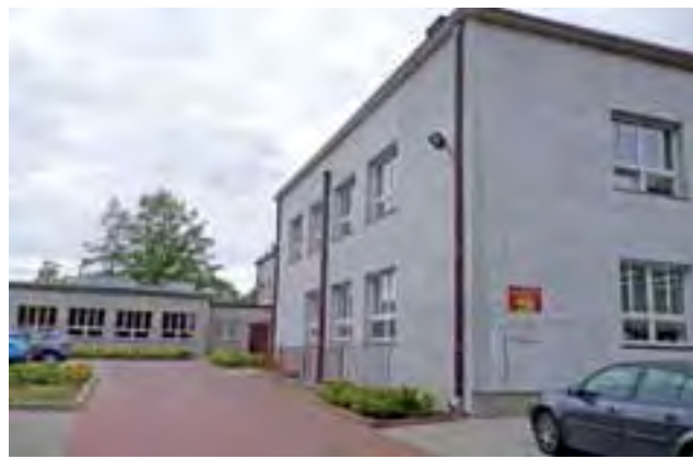
Szkoła Podstawowa w Kozlu – obecnie lekcje WF odbywają się w widocznej na zdjęciu przybudówce.
