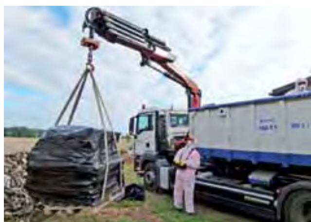
Zgromadzone i zabezpieczone folią płyty eternitu trafiają na samochód firmy Tönsmeier.
