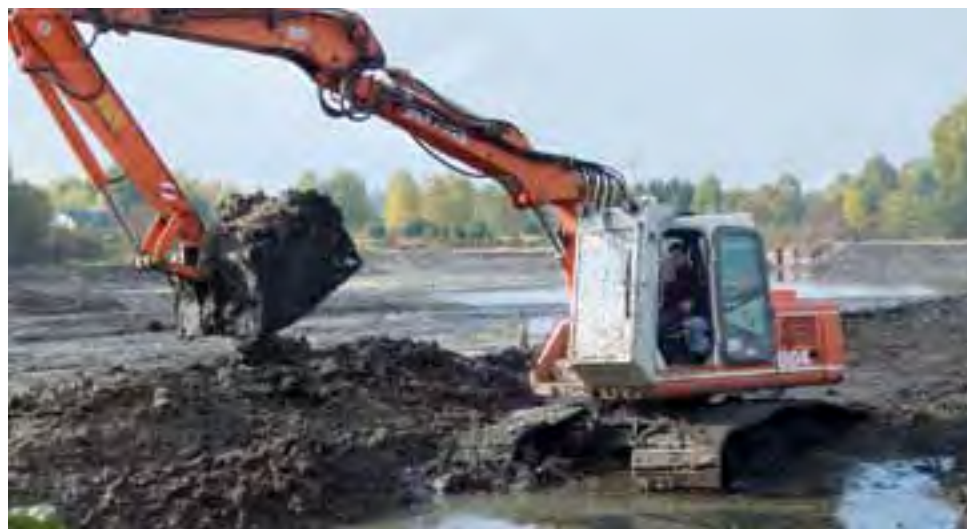
Koparki przerzucają tony mułu, oczyszczając staw w Warszewicach jednocześnie w kilku miejscach.
