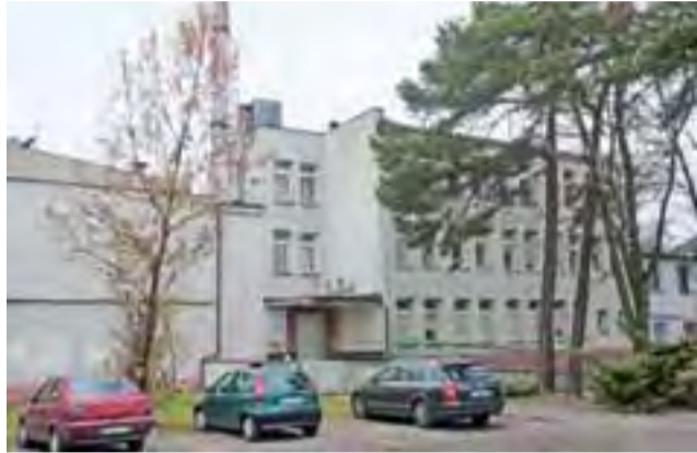
Szpital w Głowniu. Piec olejowy, którym obecnie ogrzewany jest budynek, jest przewymiarowany, a paliwo – kosztowne. Dlatego pojawił się pomysł modernizacji i zmiany paliwa na biomasę (pelet).
